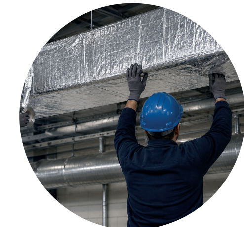
1. ÉTANCHÉITÉ DES CONDUITES
