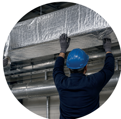
1. SELLADO DE CONDUCTOS
